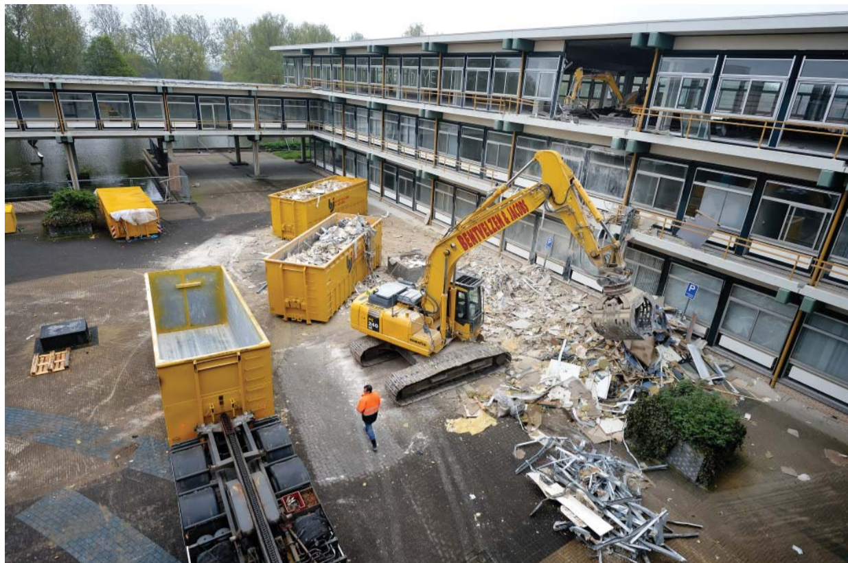
De aannemer aan het werk op het binnenterrein van het Bannehof (foto: Mike Bink)
